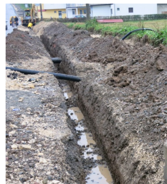
Doboj Jug - Počeli radovi na zamjeni azbestno-cementnih cijevi
